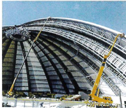
ドーム塗装 55m作業 50Tラフター
