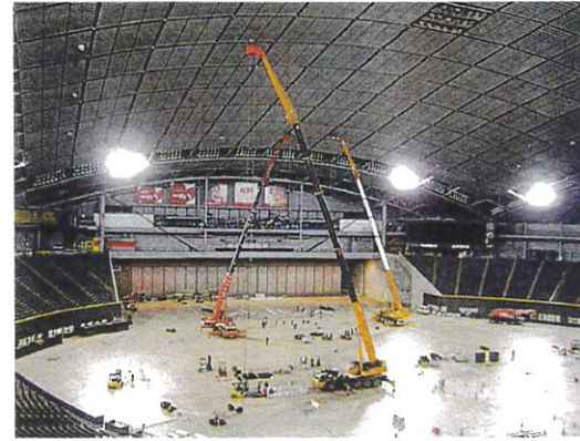
ドーム内 コンサート会場設営 60m作業 120Tクレーン
