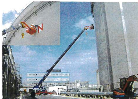
LNGタンク看板作業 半径25m 50Tラフター
