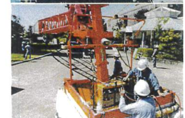
100m観音像リニューアル 100m作業 360Tクレーン
