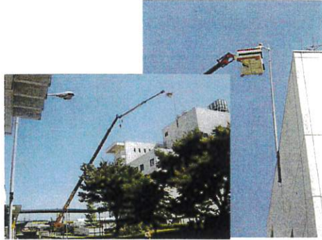
避雷針交換作業 半径30m 50Tラフター
