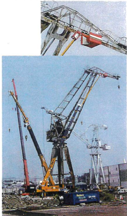
造船所クレーン解体 50m作業 50Tラフター
