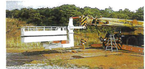
SS-300 50Tラフター取付
