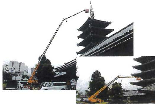
五重塔メンテナンス 50m作業 60Tラフター
